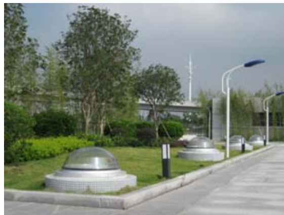
广州南站光导照明室外集光器
